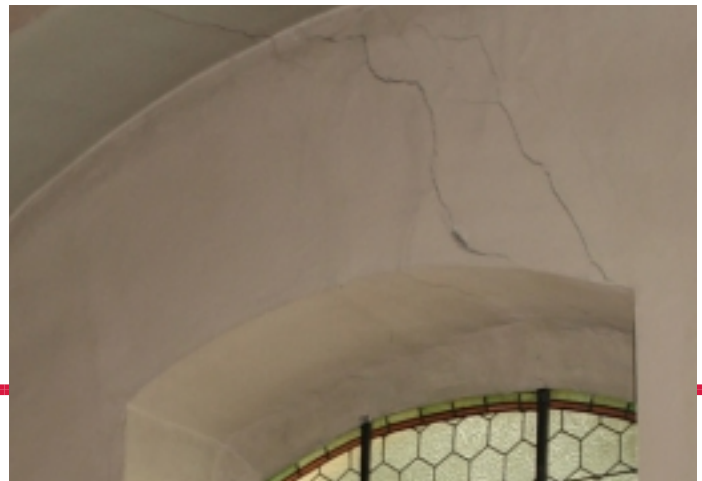
Im Bild einer der vielen Sprünge in den Kirchenwänden.
